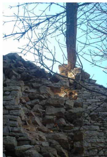
Poutre au dessus de la ruine du presbytère
