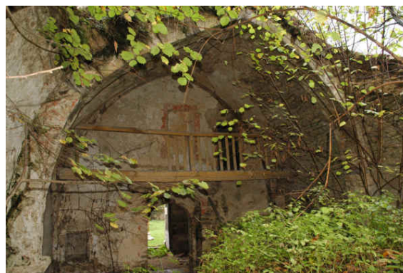
Voûte de l'avant-nef
